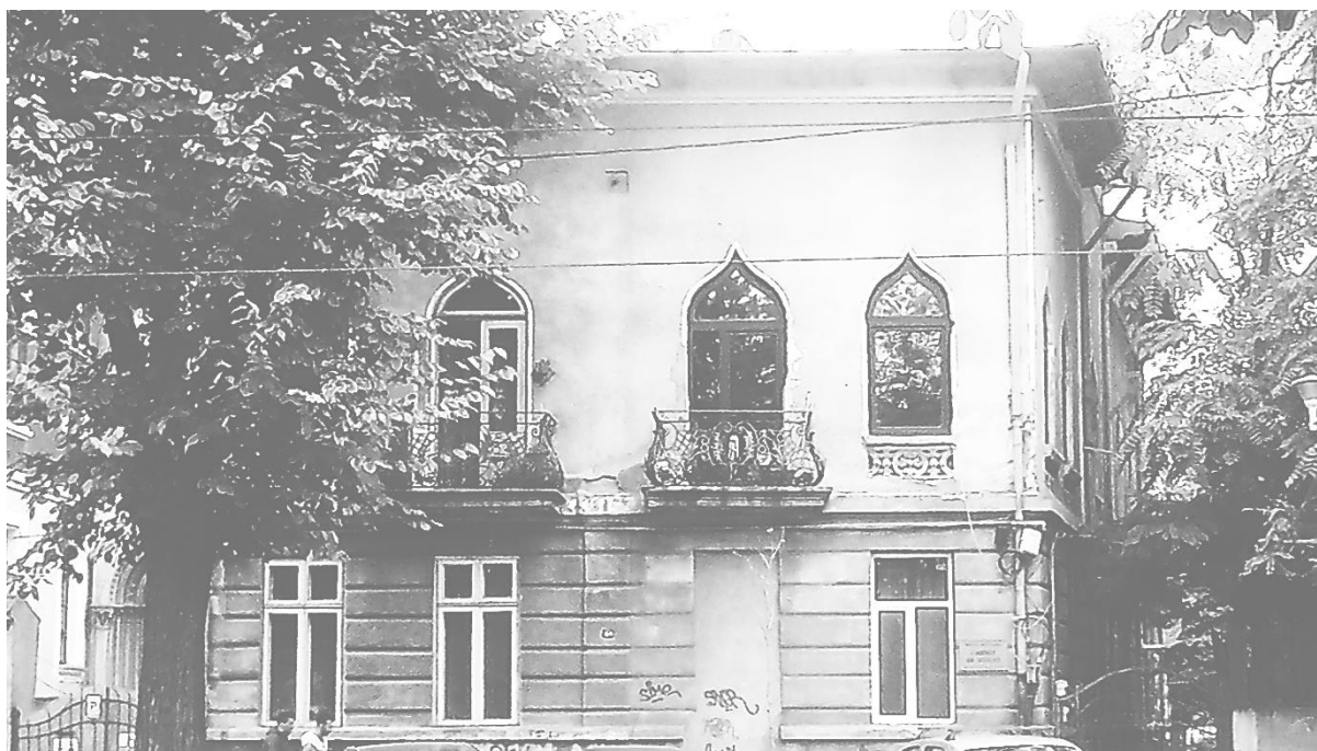
Bulevardul Pache: între Liceul Mihai Viteazu și Institutul de Construcții
